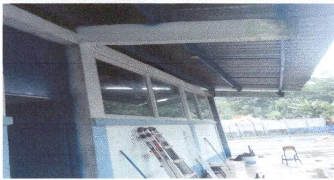
Foto 1: Cubierta de lamina y Estructura de Techo
