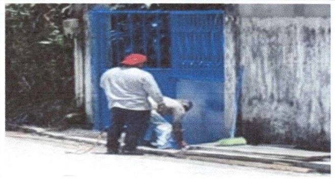
Foto 2: Mantenimiento de Portones
