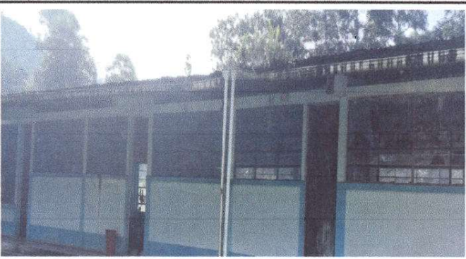
Foto 4: Canales y Bajadas de Aguas Pluviales
